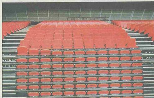
Quand la tribune se replie, une rangée avale l'autre et les fauteuils se replient automatiquement.
